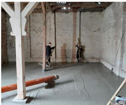
Renovierung unserer alten Scheune
